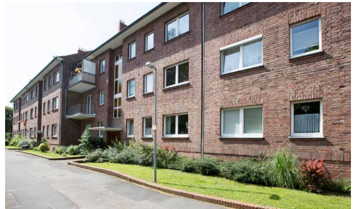
Für das Jahr 2024 ist die Umzäunung des Müllplatzes vorgesehen.
