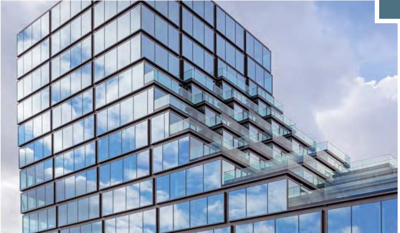
Amsterdam, „Terrace Tower“
